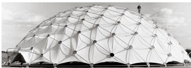
FONTE: Donald E. Ingber (1998); “ The Architecture of Life ”; Scientific American Cúpula geodésica, suporta uma determinada carga com o mínimo de materiais de construção.
